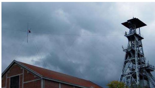
Traversée funambule entre 2 des chevalements du site minier d'Arenberg lors de l'événement "Traversée(s)" ©Mission Bassin Minier
