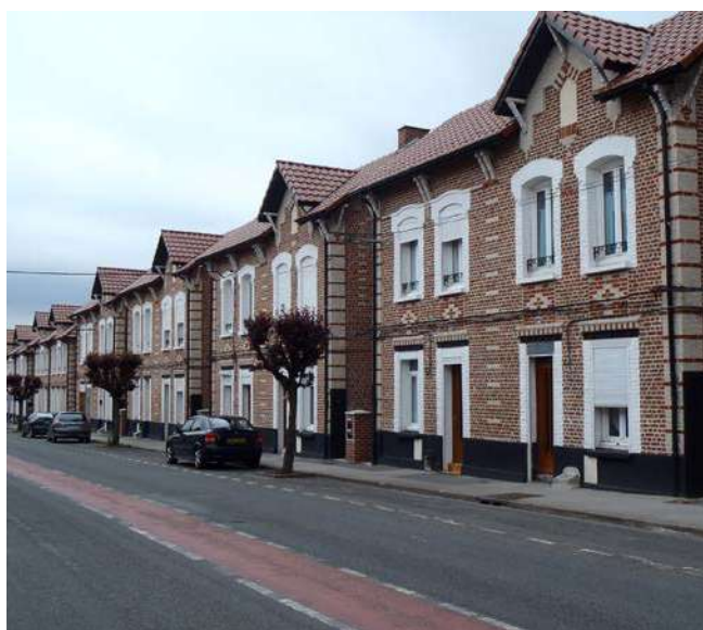
Cité du Nouveau Monde, Bruay-La-Buissière ©Mission Bassin Minier
